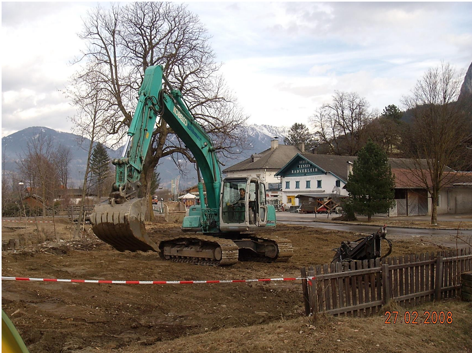
chronik-amlach-almi-Abriss Haus Winkler-2008
