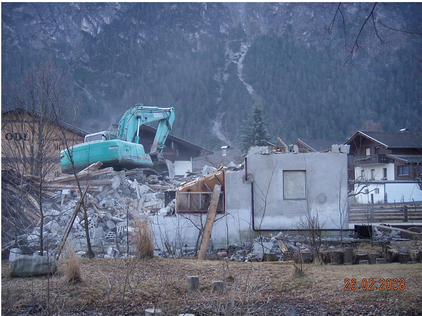
chronik-amlach-almi-Abriss Haus Winkler-2008
