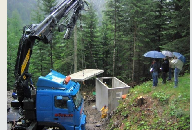
Neue Quellfassung Bruchbachl 2005
