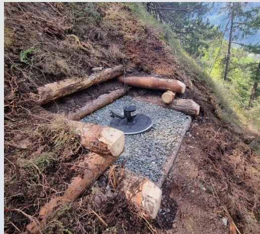
Fertig eingebaute Quellstube im Leidental 2022
