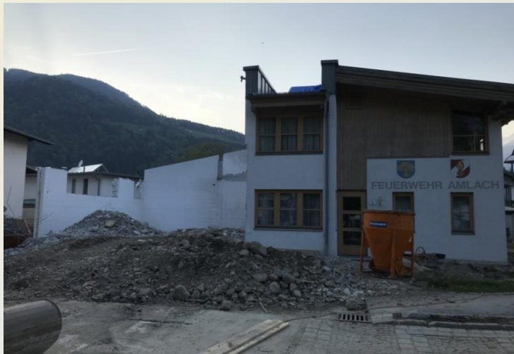
April 2018 Baubeginn Teilaberiss Feuerwehrhaus
